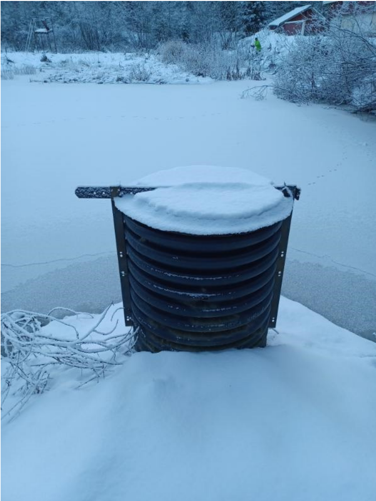
Kuva 5 Näytteenottokaivo, joka oli lukittuna.
